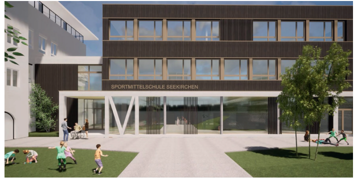
Der neue Teil der MS wird in Holzbauweise errichtet | © Two in a Box
