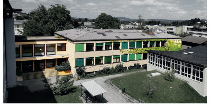
Der „Neubau-Teil“ wird in den Ferien abgerissen | © Eisl-Berger
